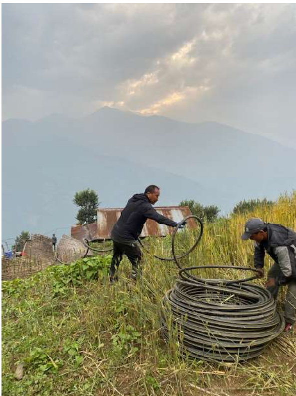
Überall mussten die Rohre ausgerollt und verteilt werden, bevor man sie eingraben konnte.
