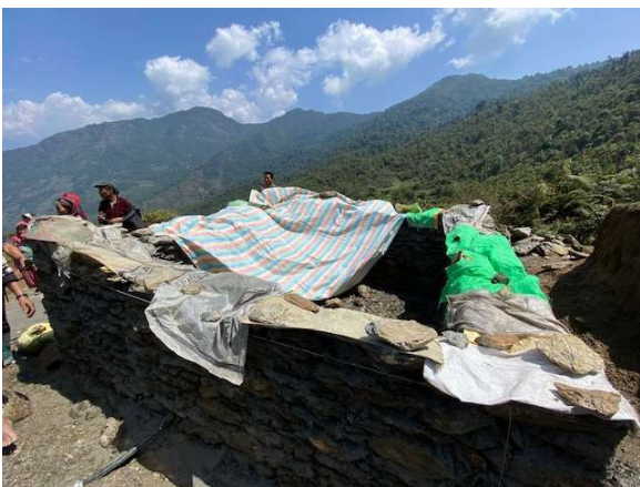
Nun wurde gemauert. Immer, wenn es regnete, musste das Mauerwerk abgedeckt werden.
