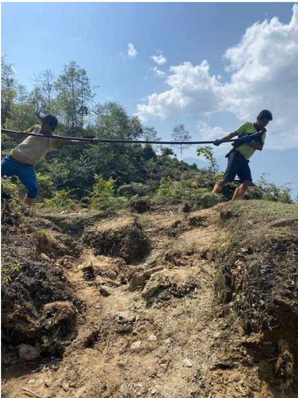
Überall mussten die Rohre ausgerollt und verteilt werden, bevor man sie eingraben konnte.
