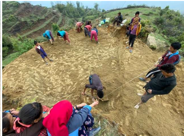
Am Seil wurde die Schaufel mit Erde nach oben gezogen, da es keine Schubkarren gibt.
