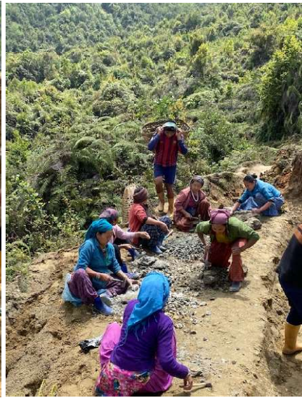
Am Rande der Baustelle saßen die Frauen und hauten Steine für den Beton klein.
